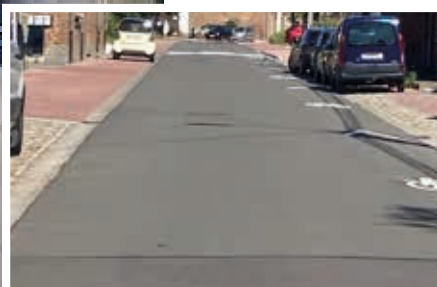
Réfection de la rue de Trazegnies (Montant à ce jour de 2.256.306,82€)
