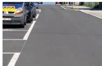
Traçage et signalisation rue de Leernes
