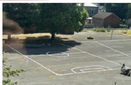
Traçage d'un terrain de football dans la cour de l'école de la Pierre aux Fontaines
