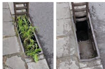
Nettoyage des avaloirs
